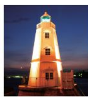
堺に現存する最古の木製洋式灯台
